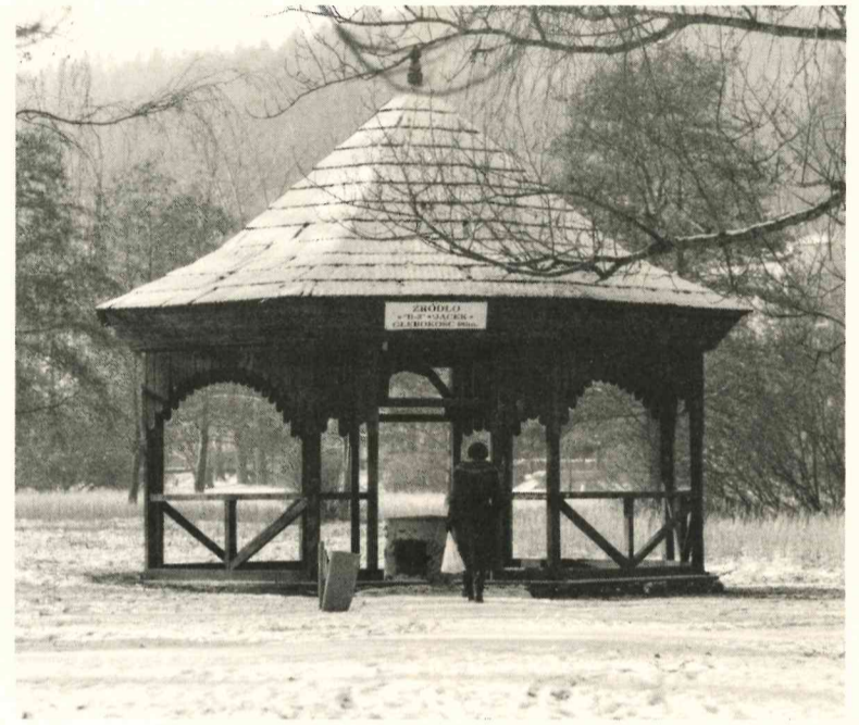
W ramach inwestycji zmodernizowane zostaną ujęcia wód mineralnych „Jacek” i „Agata”
