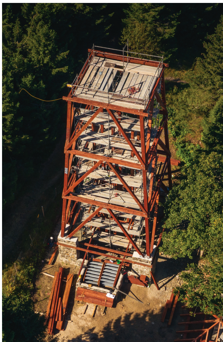
Trwają prace budowlane na najwyższym szczycie polskiej części Gór Orlickich. Obecnie wykonawca montuje drewnianą konstrukcję wieży. Budowa postępuje zgodnie z harmonogramem prac przedstawionym w ofercie na wykonanie inwestycji, która powinna zakończyć się do 30 listopada br.
