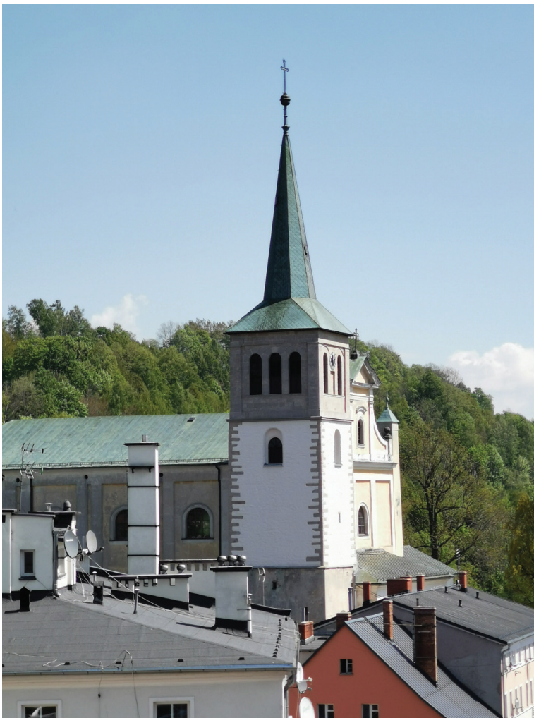
W związku z tym, że parafii nie udało się pozyskać środków zewnętrznych na realizację drugiego etapu modernizacji kościoła, fundusze przeznaczone z budżetu gminy na wkład własny radni postanowili wykorzystać na inny cel
