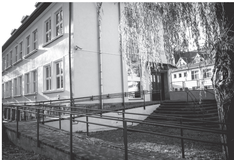
Podczas tegorocznych wakacji biblioteka przeniosła swoją siedzibę z ul. Zdrojowej do budynku przy Szkole Podstawowej. Zyskała nie tylko nowe pomieszczenia ale i podjazd dla niepełnosprawnych czy wózków dziecięcych
