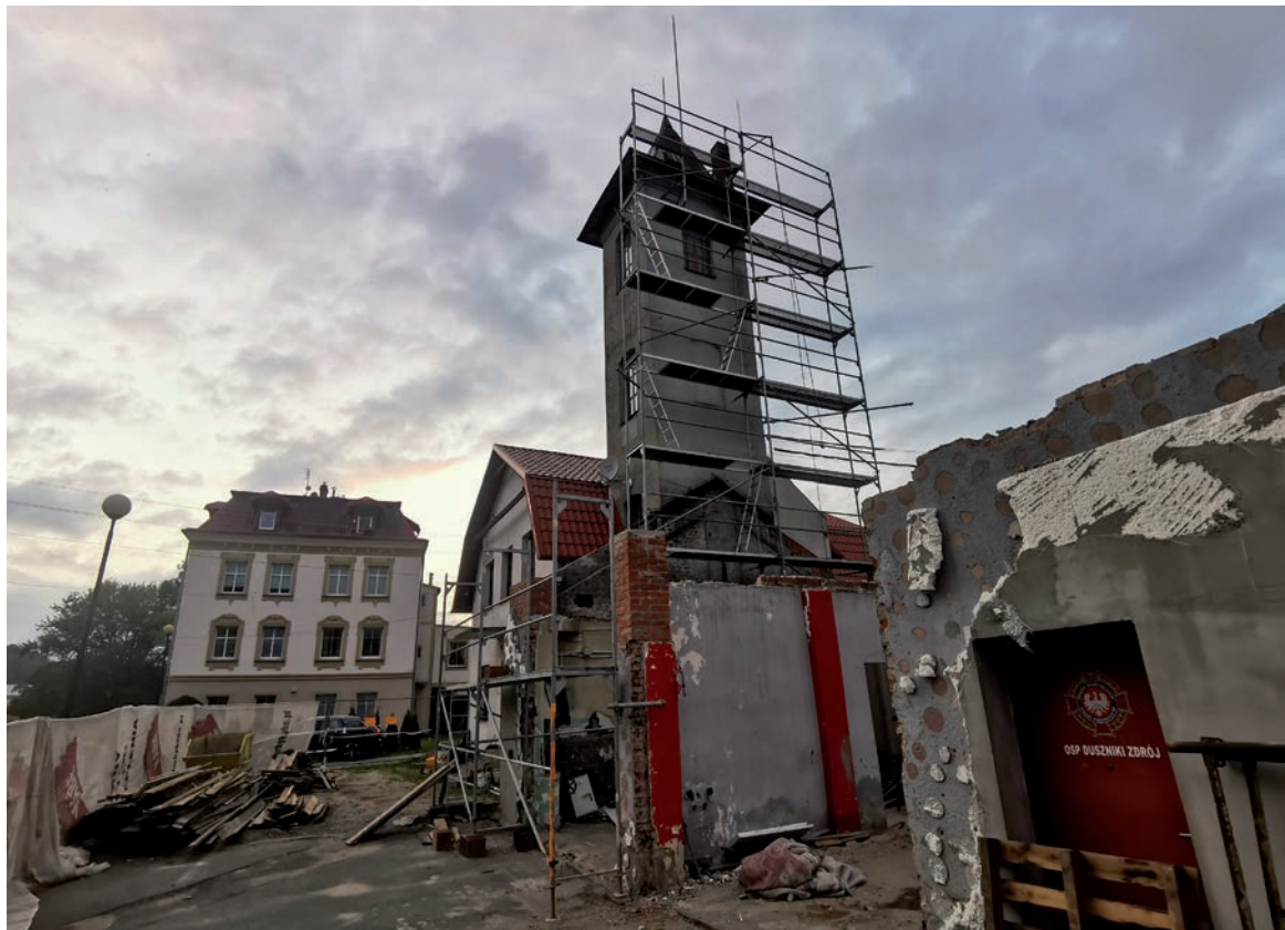
Prace przy modernizacji remizy strażackiej postępują w większości zgodnie z harmonogramem prac
