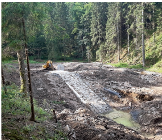
Budowa zbiorników na Czerwonym Potoku, koło Filtrów
