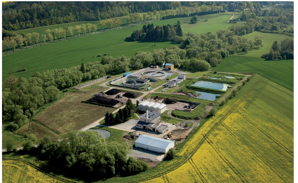
Sławomir Szymaszek prezes DZK Sp. z o.o.: W tej chwili dopłacamy jako zakład ok. 3,30 zł do każdego metra sześciennego wody i ścieków. Na fotografii oczyszczalnia ścieków w Polanicy-Zdroju, która obsługuje dusznickie wodociągi
