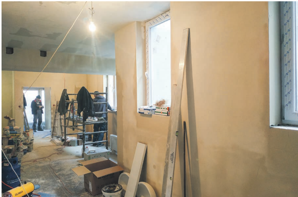
Prace w nowym Klubie Seniora potrwają do końca stycznia 2021 roku. Za realizację inwestycji odpowiada dusznicka firma budowlana Krzysztofa Onyszczyka
