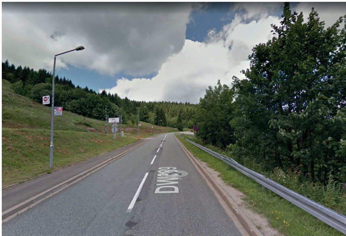
108 tys. zł dofinansowania pozyskała gmina na wymianę 81 opraw oświetlenia ulicznego w Zieleńcu
