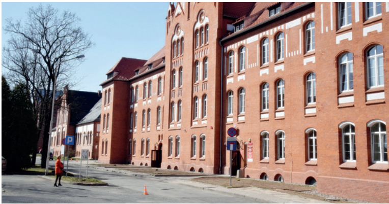
Terenowy Punkt Paszportowy w Kłodzku mieści się w nowym budynku Starostwa Powiatowego przy ul. Wyspiańskiego, na terenie byłych koszar
