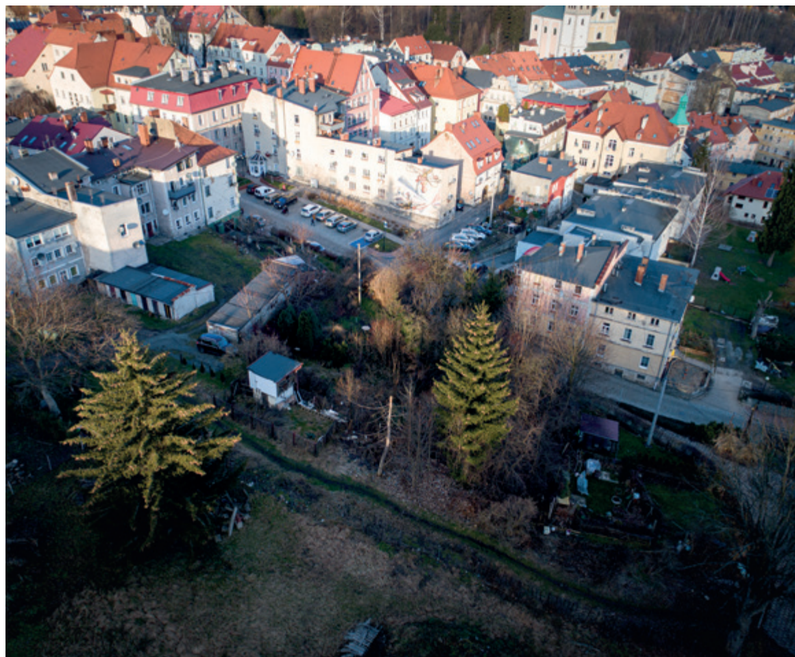
Na tej działce przy ul. Krakowskiej gmina planuje wybudowanie nowych mieszkań komunalnych
