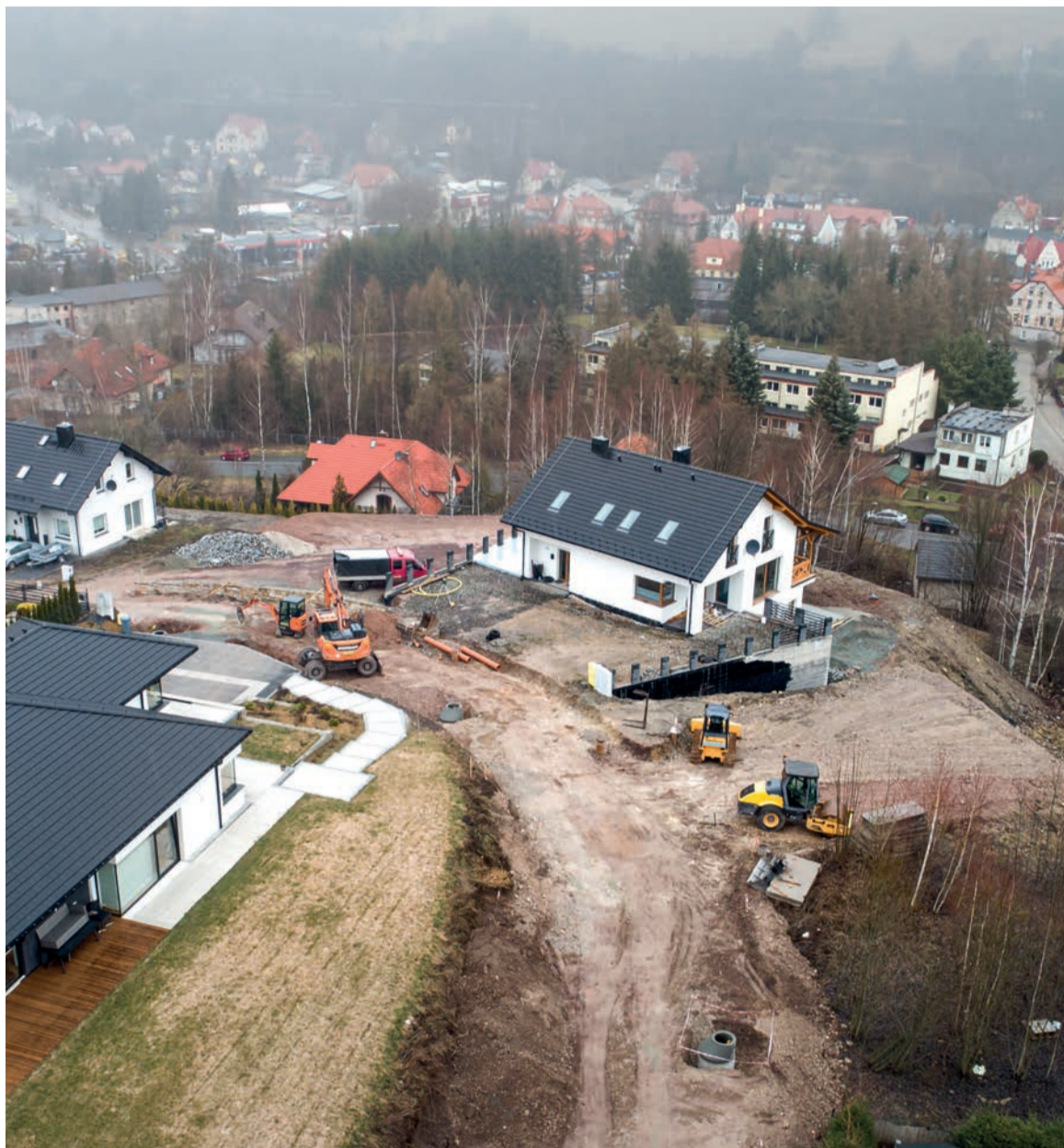
Rozpoczeto inwestycje na Miejskiej Górze. Prace potrwa do końca roku
