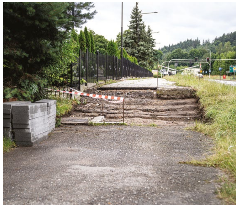
Schody przy drodze krajowej nr 8 zostały wyremontowane
