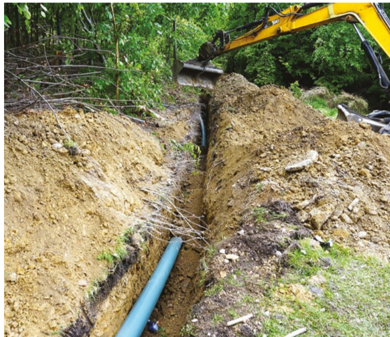
Budowa nowej nitki kanalizacji przebiega zgodnie z harmonogramem prac
