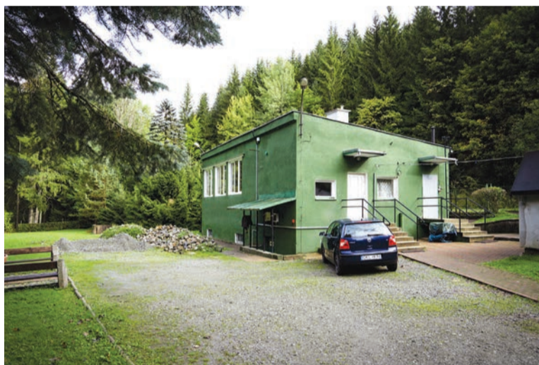
Stacja uzdatniania wody
