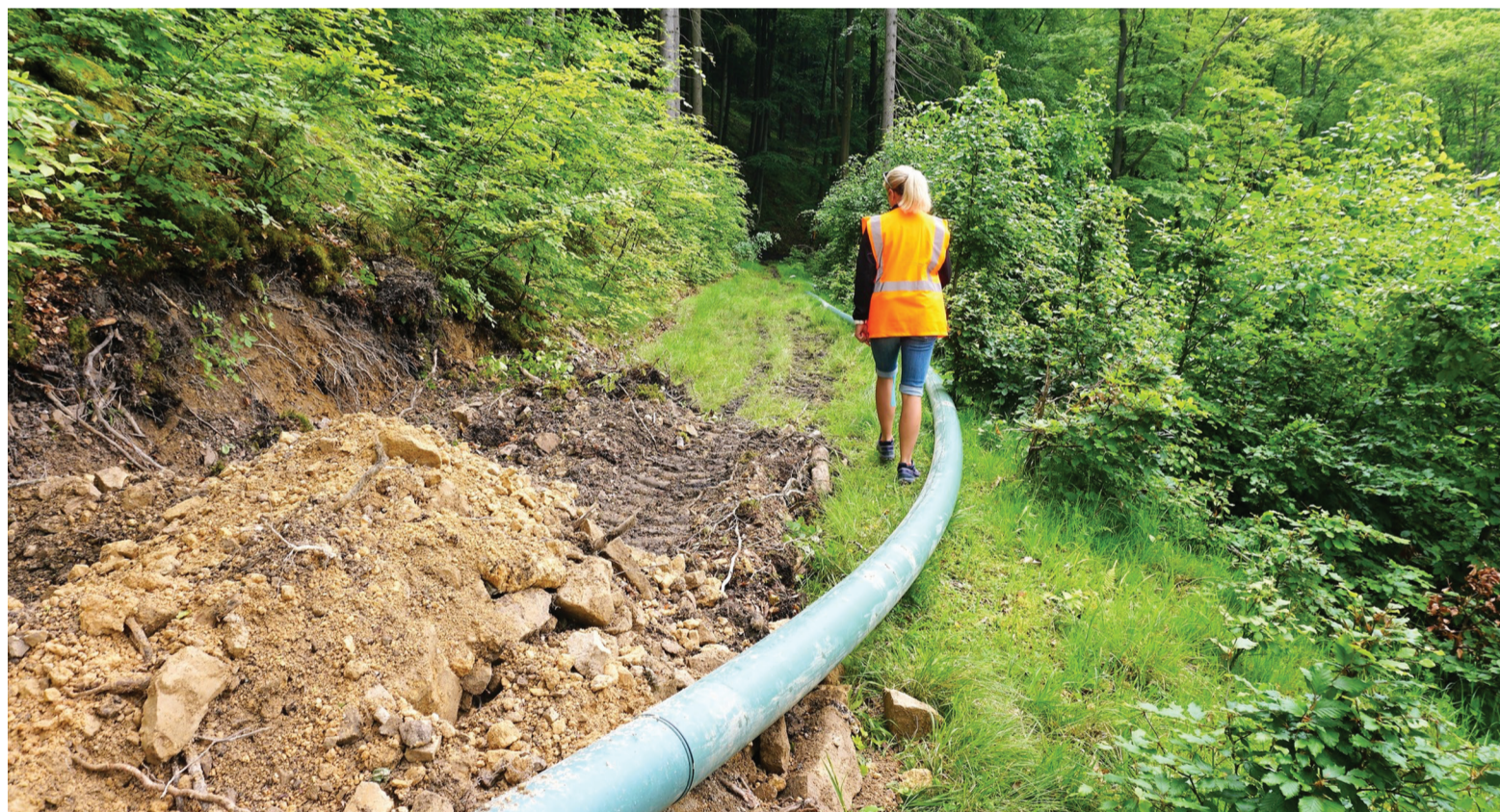
Nowa nitka kanalizacji kosztowała ponad 10 mln zł
