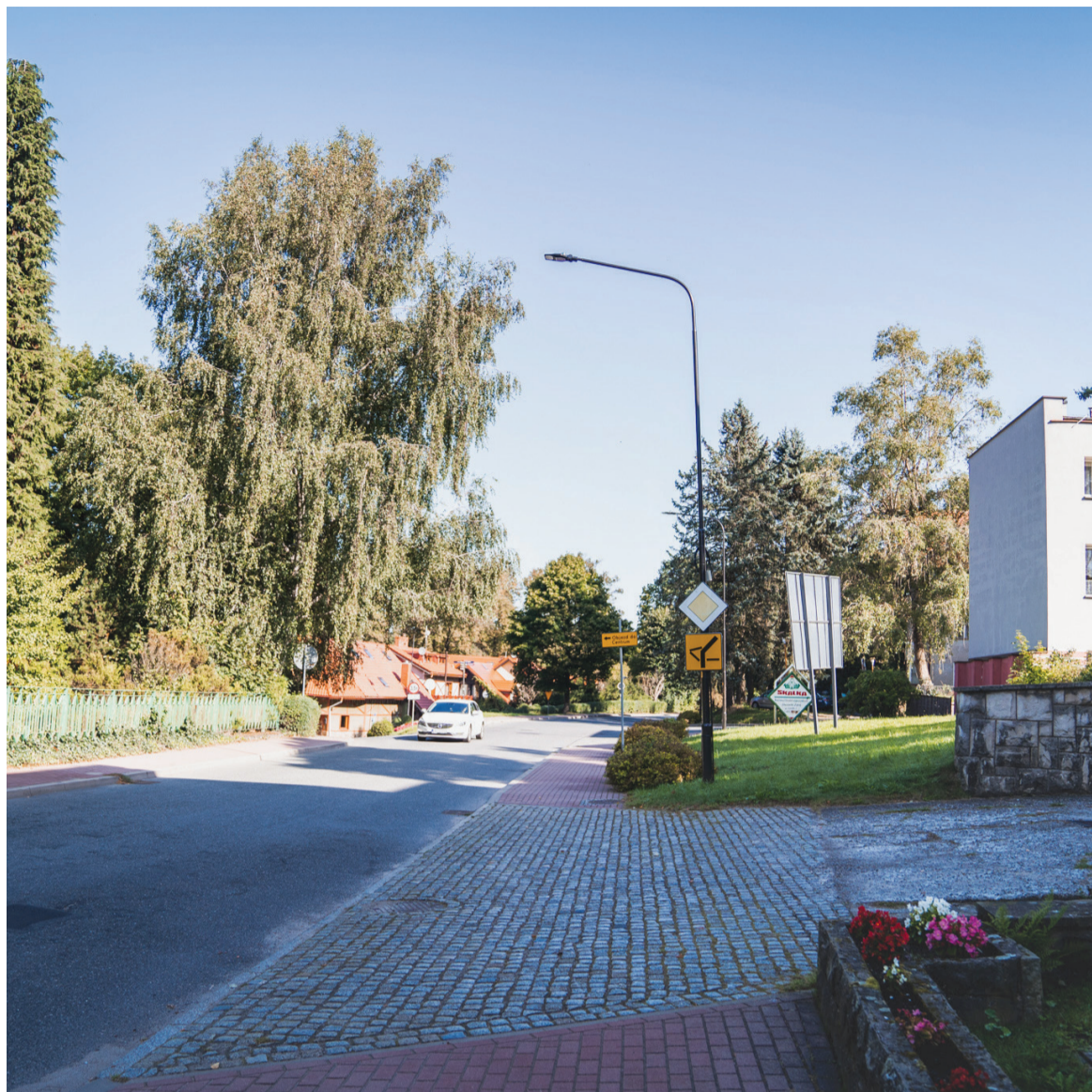
Oświetlenie uliczne na terenie całego miasta jest sukcesywnie wymieniane na energooszczędne
